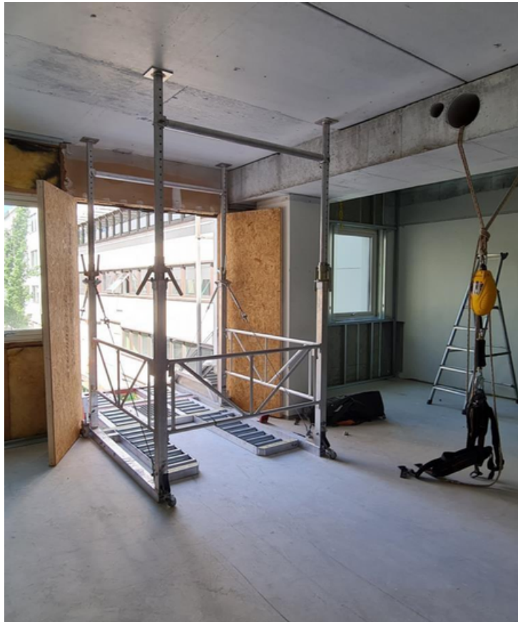
ConstructaAS og MoelvenModusAS—Office Building, Bergen
