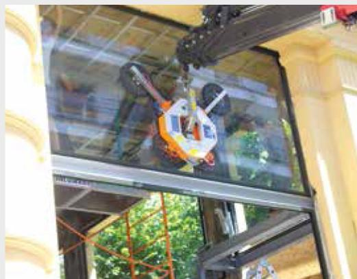
Anneau de guidage en option : Réduit l'épaisseur du palonnier à 14 cm - capacité maxi 300 kg
