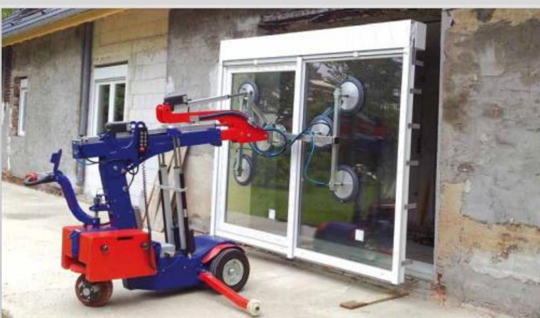
Télescopage, levage et abaissement électrique grâce à une commande synchronisée de qualité.
